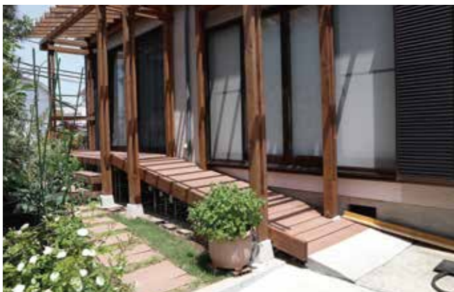
スロープを設置して車椅子の方も気軽に訪れることができるようにした。
