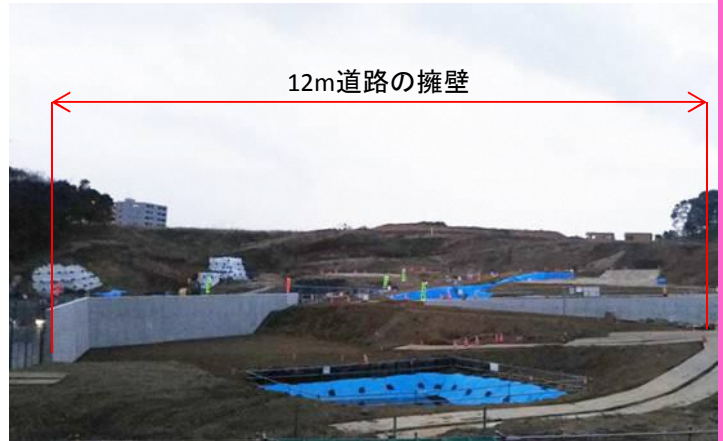
擁壁施工状況
