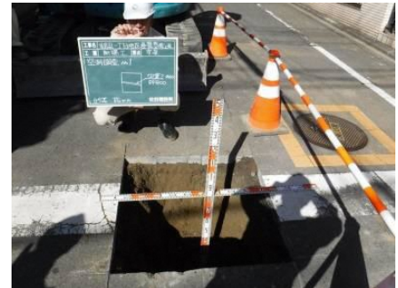
試掘状況写真
