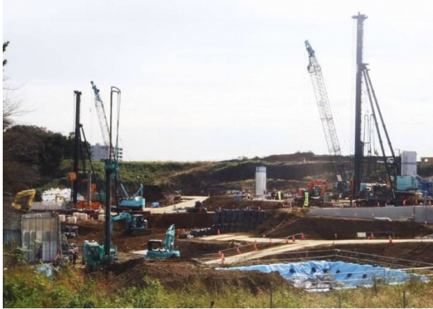
擁壁基礎杭施工状況
