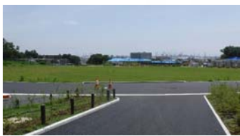
写真① 北側道路付近の入口
