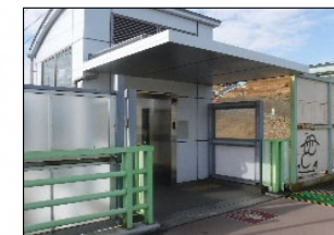
エレベーター
