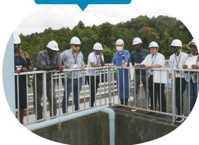
最終処分場の排水処理施設
