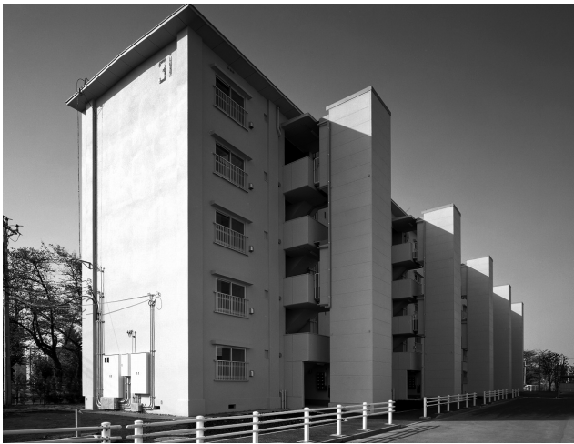
▲後付けエレベーターの例
