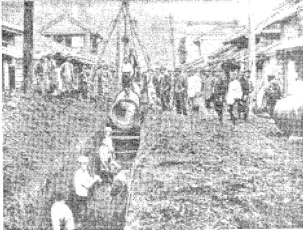
口径36インチ配水管布設工事
