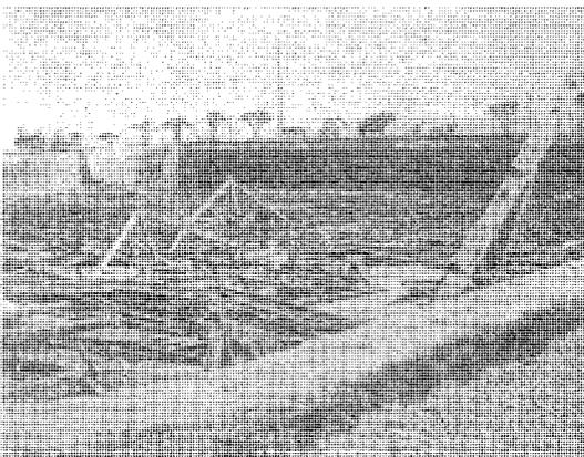
関東大震災で崩壊した野毛山浄水場配水池（大正12年）
