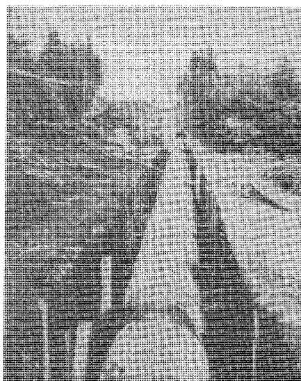
口径1,500mm 鋼弦コンクリート鋼管布設工事
