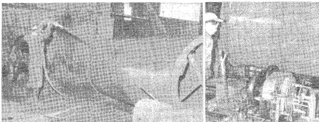
鋼弦コンクリート鋼管の製作（グナイト吹付けとピアノ線巻付け）を与え強化を図ったもので、耐久・耐蝕性には富んでいたが、衝撃に対しては弱いため、布設工事中に管が滑り落ち、亀裂を生ずる事故があったので、その後更に管軸方向に鋼棒を入れて締め付けるように改良した。
