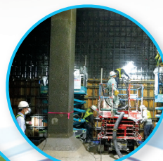
耐震補強工事
