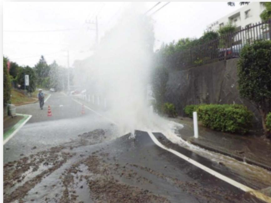
老朽化による水道管の破裂事故
