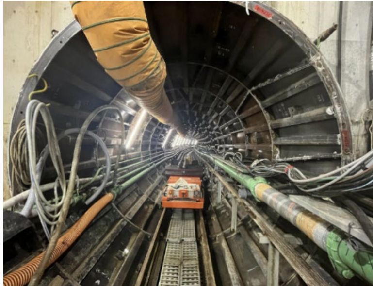
相模湖系導水路（川井接合井から西谷浄水場）改良事業 シールド工
