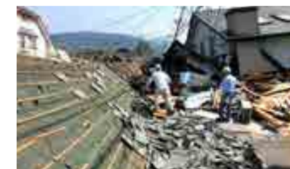
地震で倒壊した家屋(2016年熊本地震)
