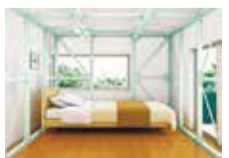
▲耐震シェルター
