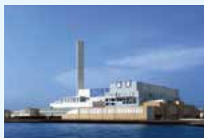
焼却工場（金沢工場）
