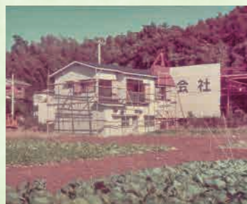
鴨居に建設中のおくだ動物病院
