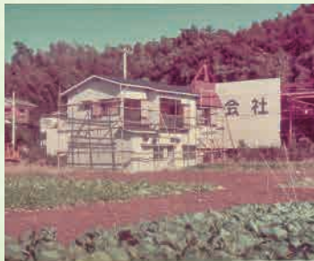
鴨居に建設中のおくだ動物病院
