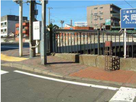
橋と歩道をつなぐ急勾配部分。 道路標識、照明、サイン等が乱立し、狭い。
