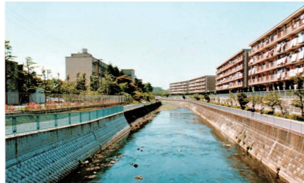
写真2 (城山橋から下流を望む)
