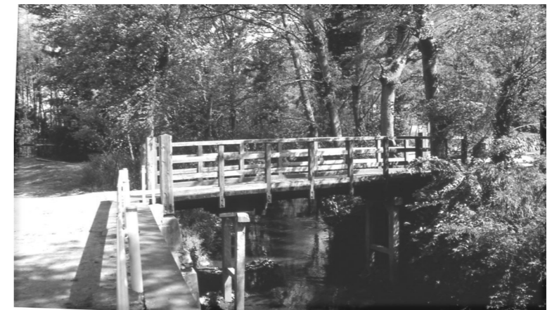
【旧小長谷橋】昭和期まで木製の橋で橋長6m位でした。
