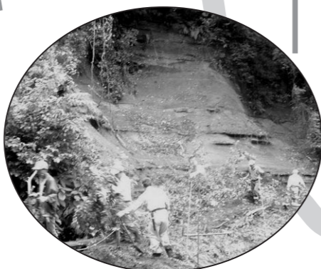
上荒井沢：荒井沢谷戸の崖崩れ
