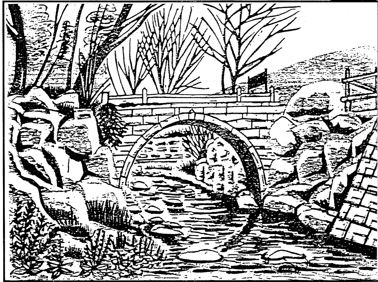
《昇龍橋》現存する横浜市内で最古の石造アーチ橋といわれている。石材は鎌倉石使用。
