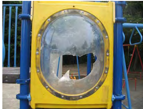
▲ ドームパネル破損
