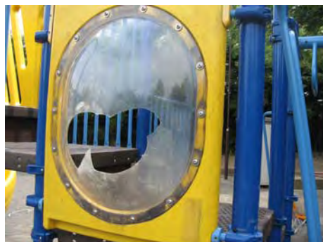
▲ 仮復旧の事例
