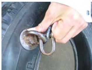
ステンレス鋼の錆
