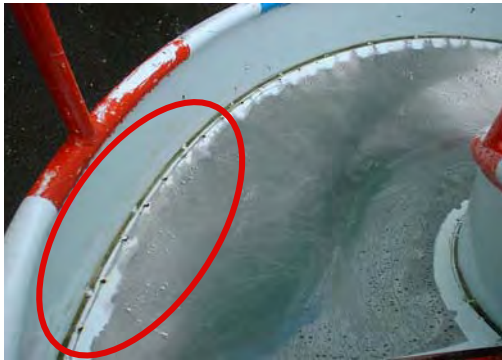
▲ 滑走部溶接部分の割れ
