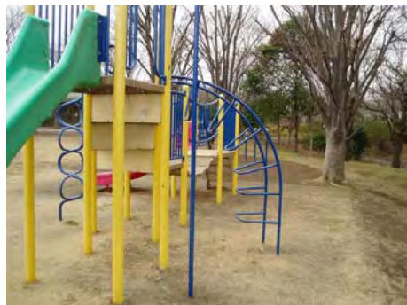
▲ 部分的な使用禁止措置の事例
