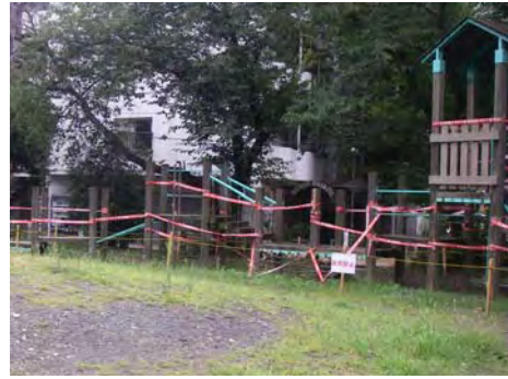
▲ 応急の使用禁止措置の事例
