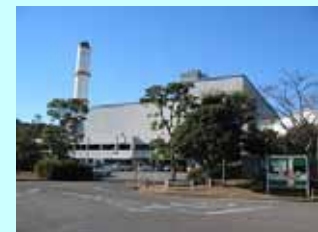
廃止した栄工場
