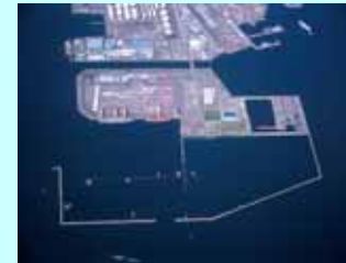
南本牧廃棄物最終処分場
