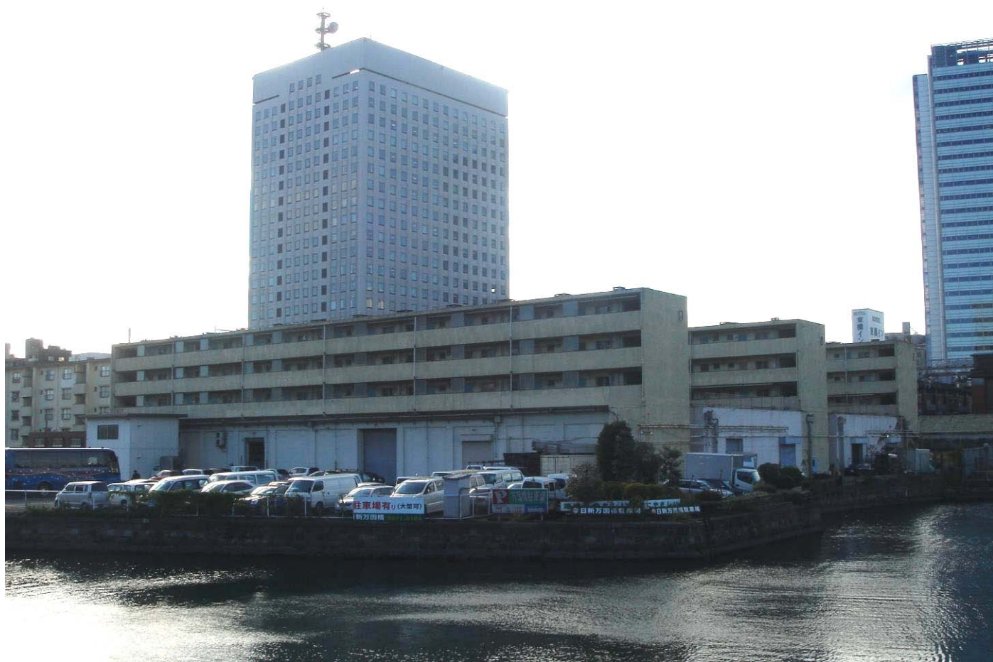
写真⑥ 自動車道からの状況
