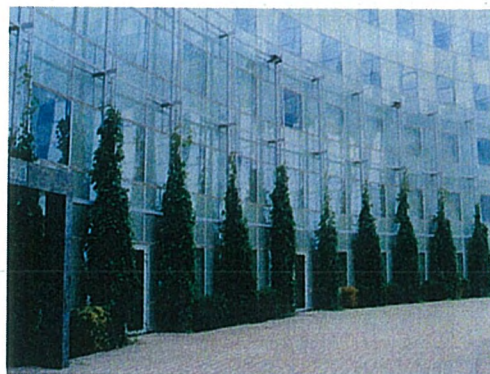
建物デザインと調和した軽快な素材の誘因施設によるカーテンウォールの緑化（パリ市）
