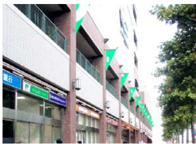
【景観計画】 秩序ある広告景観を形成するよう広告物の規格を規定
