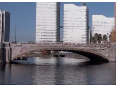
【景観計画】 島の玄関として特徴づける橋梁の形態意匠を規定
