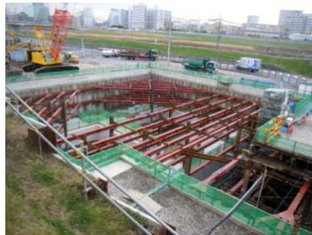
新横浜立坑工事状況
