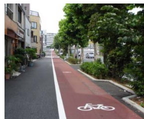
自転車走行空間整備
