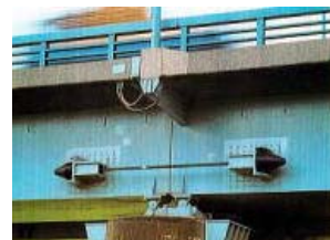
落橋防止(PC鋼棒による桁の連結)
