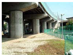
橋脚補強(鉄筋コンクリート巻き立て)
