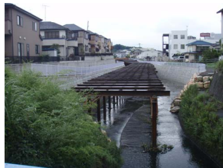
住宅地の中で改修が進む日野川
