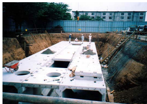
上飯田小学校の雨水貯留施設整備
