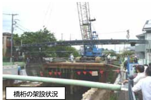
橋桁の架設状況
