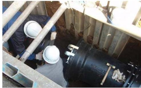
耐震管への布設替え工事
