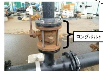
ロングボルトによる接続部の補強
