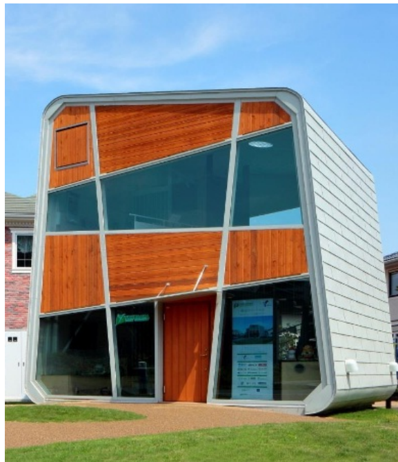
YSCによるエネルギーシステムの研究・実証実験ハウス 「スマートセル」
