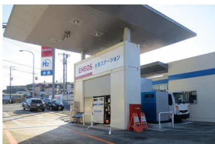
固定式水素ステーション（旭区）
