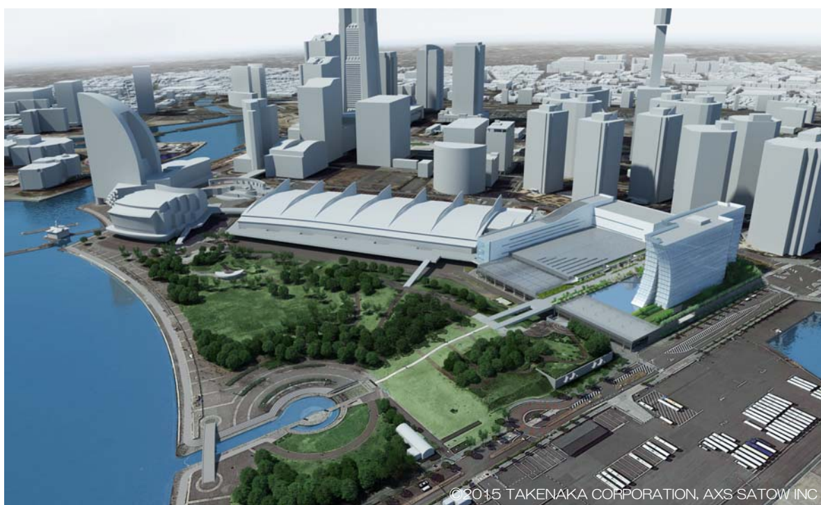
耐震バース上空より20街区を望む
