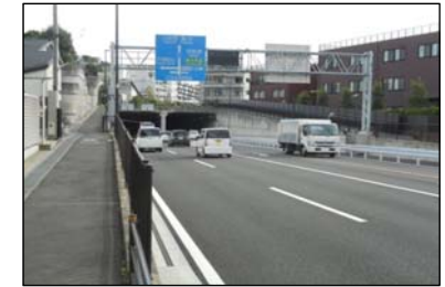
▲ 柏尾戸塚線(戸塚アンダーパス) (平成27年3月オープン)
