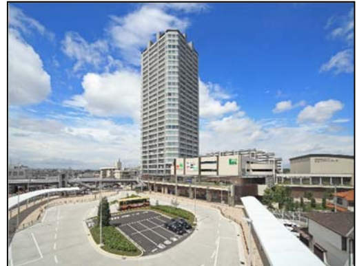
再開発後の長津田駅北口地区 （鉄道線路側（南東方面）外観）
