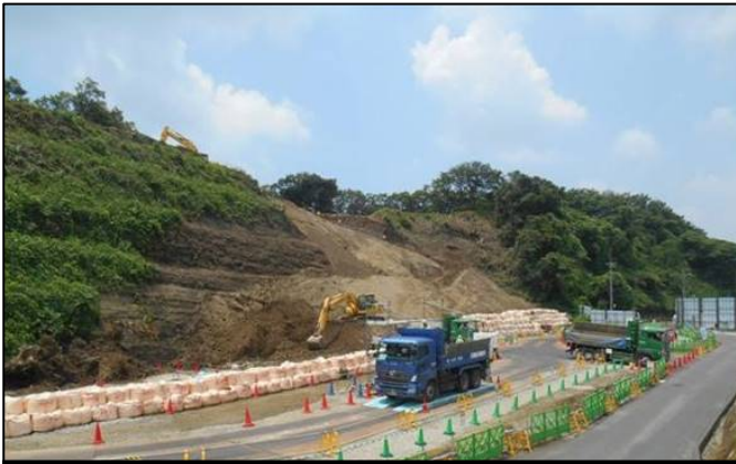
①桂台トンネル回転立坑構築のための切土工事 (栄区桂台西二丁目付近)
