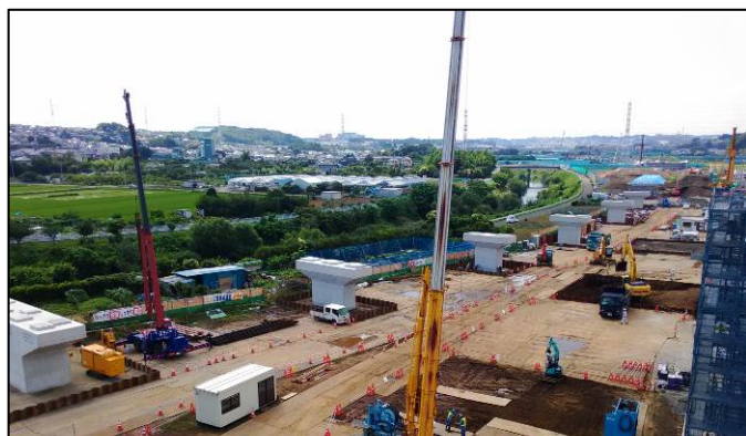
①橋脚工事（青葉区下谷本町）
