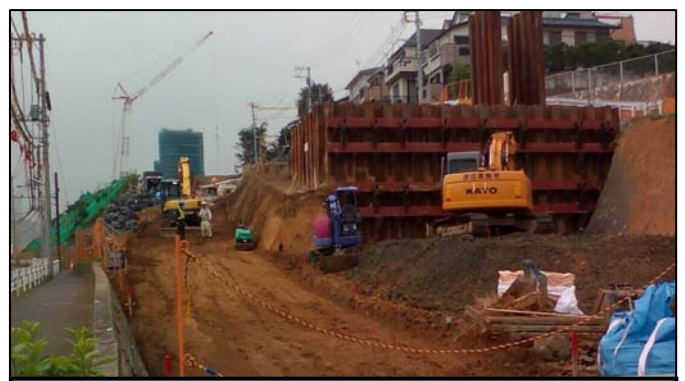
⑧大田神奈川線 擁壁工事状況(鶴見区馬場七丁目)
