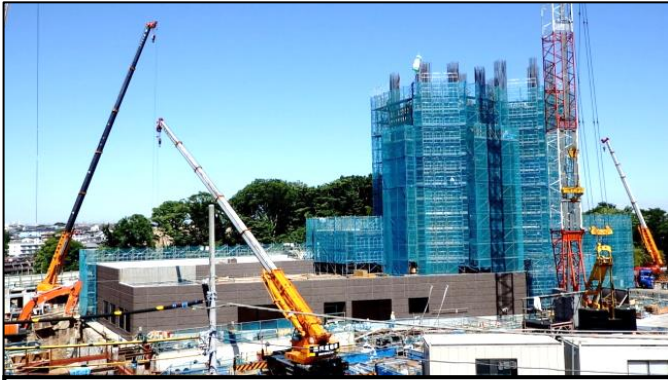
③馬場出入口部 換気所工事状況(鶴見区馬場七丁目)
