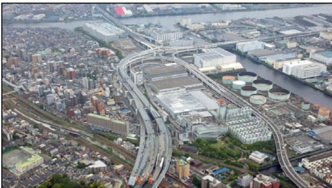
⑤岸谷生麦線鉄道交差上部工事状況(鶴見区生麦一丁目)
