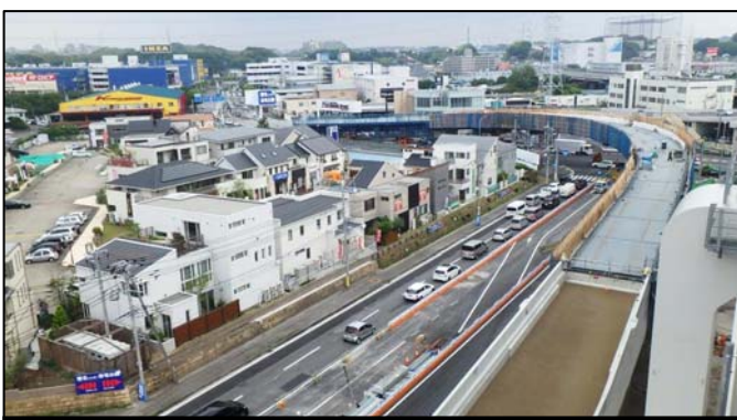
⑦川向線 右折立体部工事状況(都筑区川向町)
