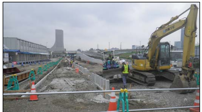
⑥長島大竹線 街路築造工事状況(港北区新羽町)
