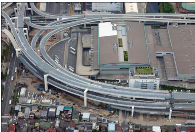
①生麦 JCT 部 上部工事状況 (鶴見区生麦一丁目)
