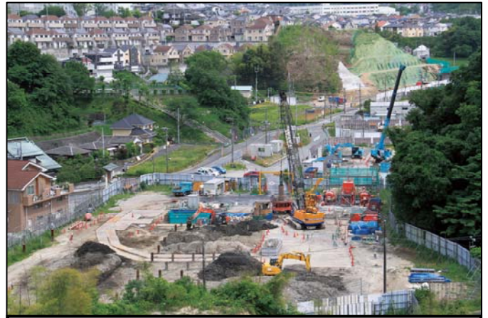
②公田地区掘削試験工事 (栄区公田町)
