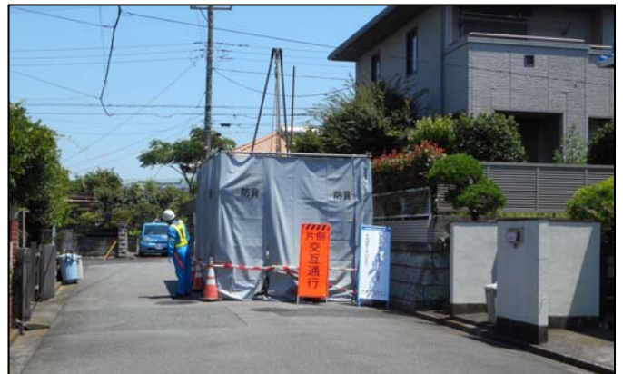
④庄戸地区のトンネル工事着手に向けた地下水位観測孔の増設(ボーリング)作業実施(栄区庄戸五丁目)
