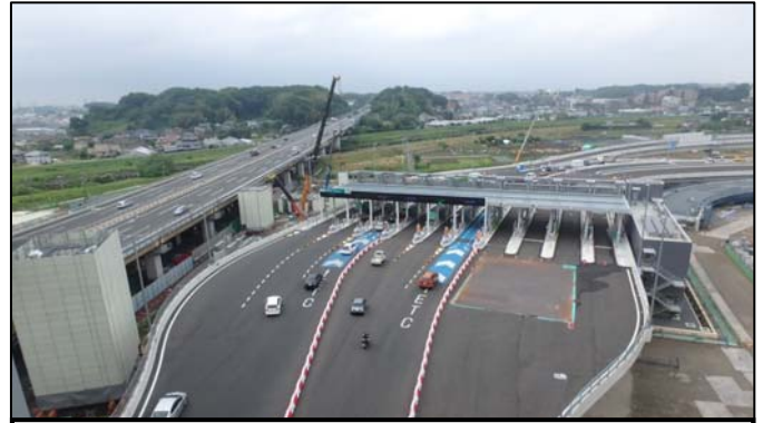
④横浜港北 JCT 部 出口切り替え状況(都筑区川向町)
