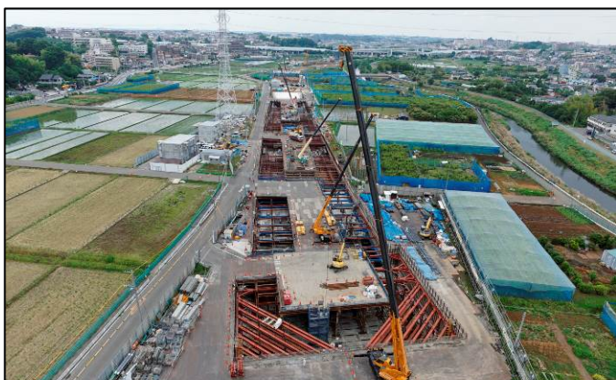
⑤発進立坑工事、開削ソコ工事（緑区北八朔町）
