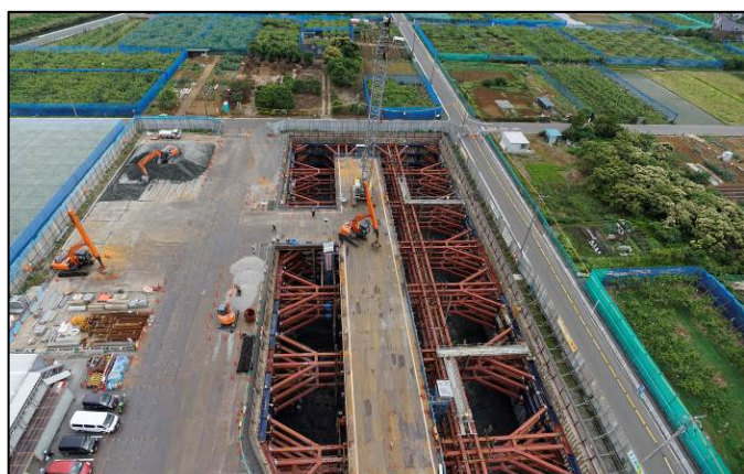
③(仮称)北八朔換気所工事（緑区北八朔町）
