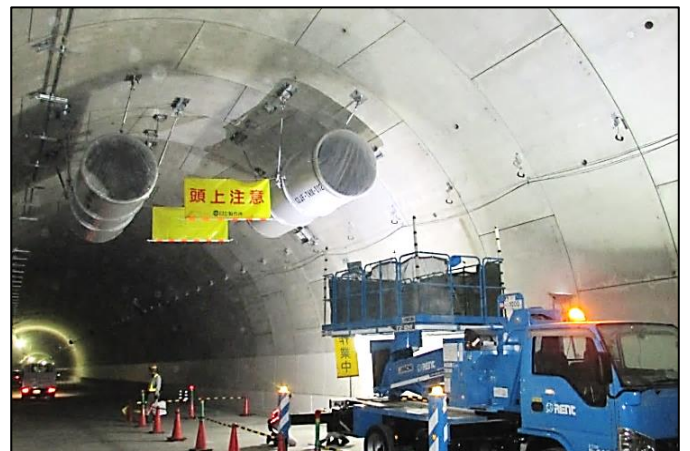
②トンネル部 設備工事状況 (神奈川区子安台二丁目)
