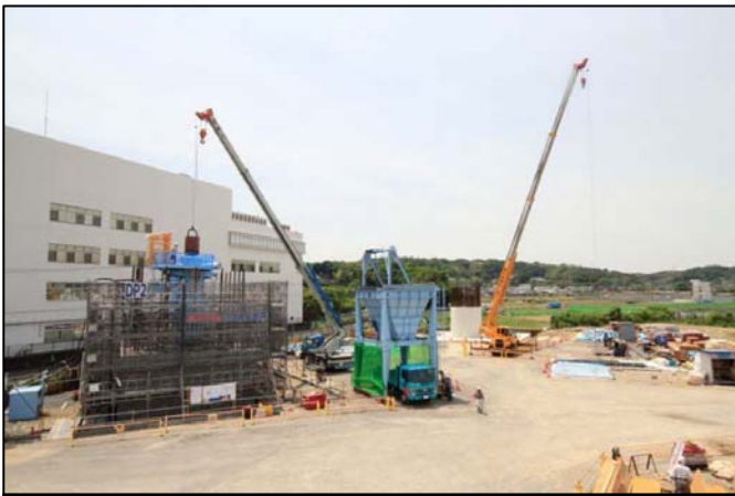
③栄 IC・JCT 下部工事 (栄区田谷町)
