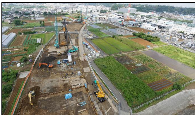
②橋脚基礎工事（都筑区川向町）
