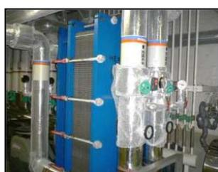
←下水再生水を利用した熱交換器
