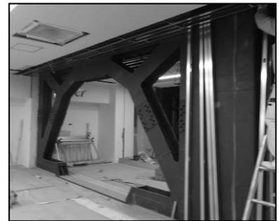
耐震改修事例（ブレース設置工事）
