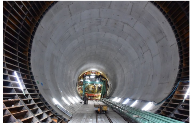
▼写真④ シールドトンネル内
