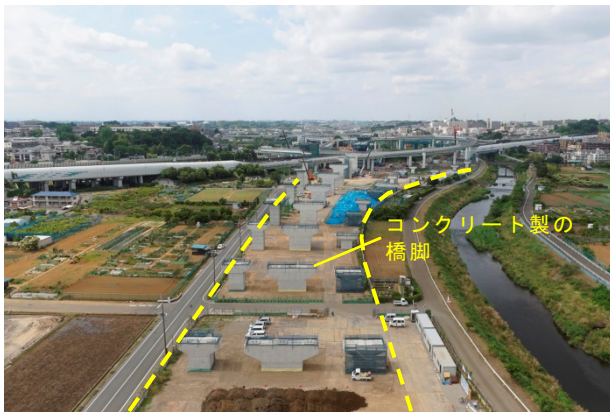
▼写真① 橋梁工事（青葉区下谷本町）
