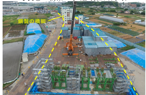
▼写真⑥ 橋梁工事（都筑区川向町）
