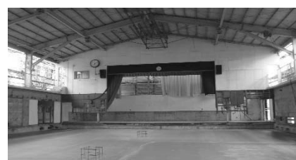
小学校体育館の改修工事
