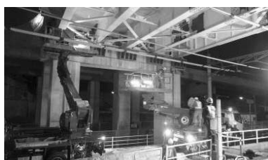
橋りょうの保全工事
