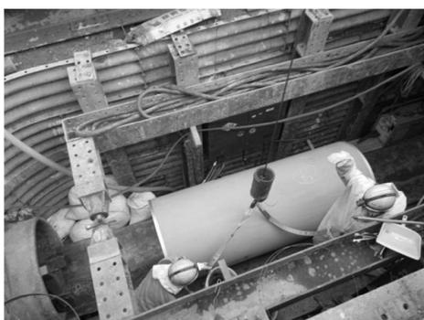
※内挿管工法：古い管の中に、サイズの小さい新しい管を挿入する工法
