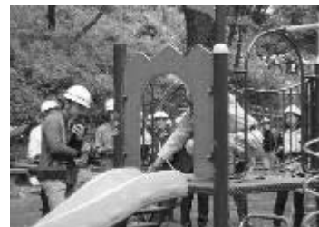
遊具の点検の例
