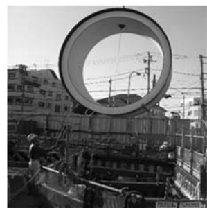
雨水幹線整備状況 （推進工法）
