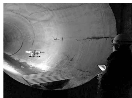
ドローンによる下水道管調査
