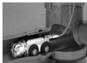
下水道管のTVカメラ調査
