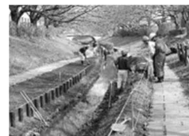
江川せせらぎ（都筑区）修繕状況
