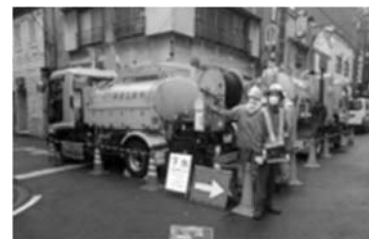
下水道管清掃状況
