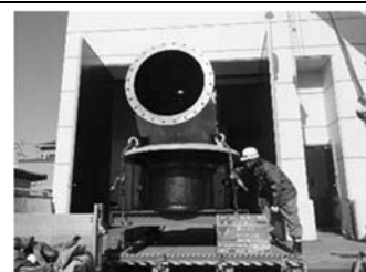
ポンプの再整備（長寿命化）
