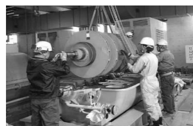
送風機の再整備（長寿命化）
