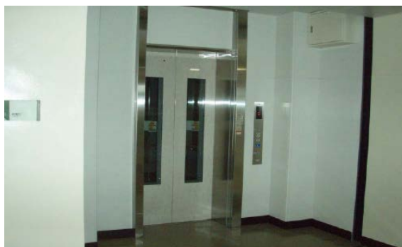
エレベーター増築棟
