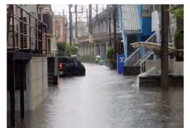
令和3年 道路冠水状況
