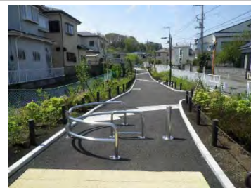
旧河川(帷子川)を活用したグリーンインフラ
