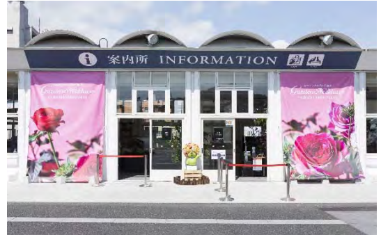
Park-PFI によりリニューアルする 山下公園レストハウス
