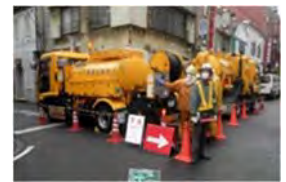
下水道管清掃状況
