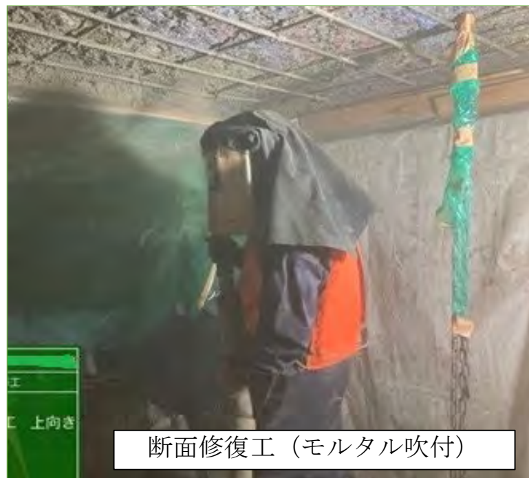
施工イメージ
