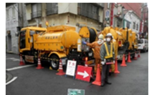
下水道管清掃状況
