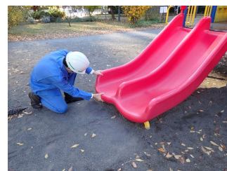
遊具点検の例
