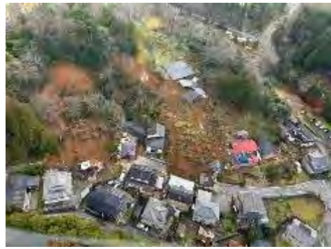
②がけ崩れによる道路途絶状況（輪島市内）
