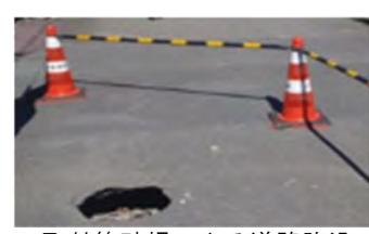
取付管破損による道路陥没
