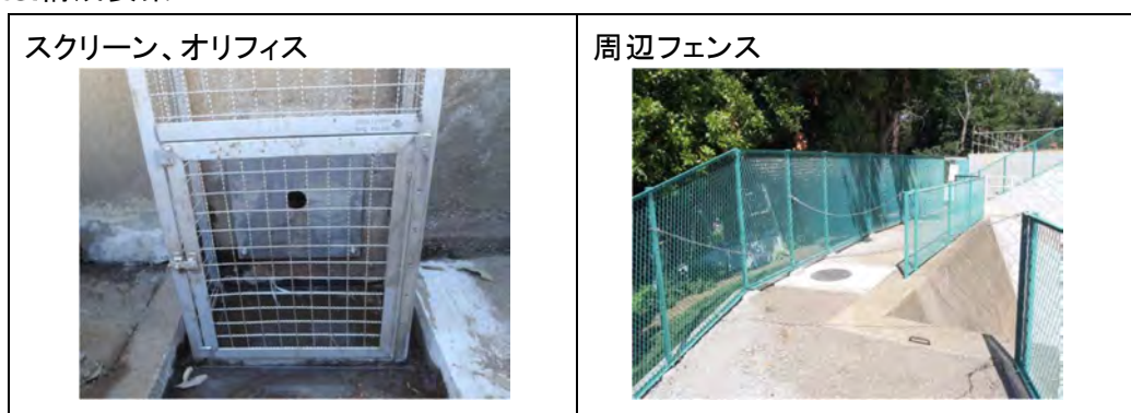
図 1-3 雨水調整池の付帯施設
