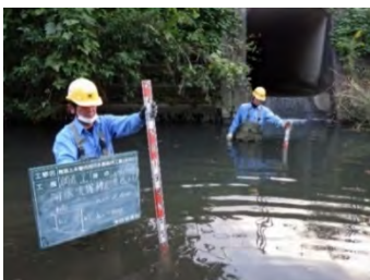
河道内の洗堀
