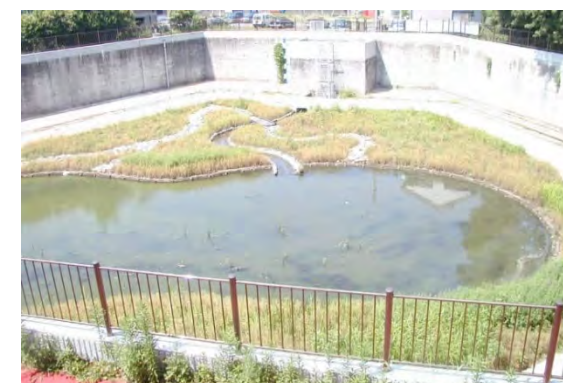
ビオトープ (三保第一雨水調整池)
