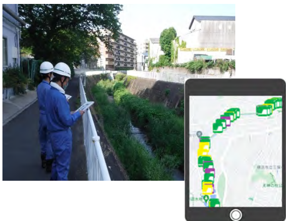
河川点検システムの活用
