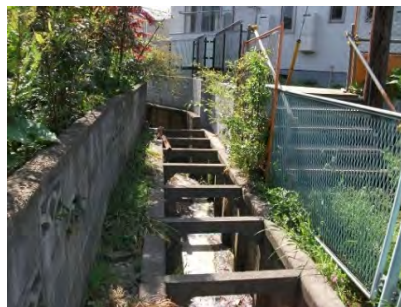
水路 (緑区 柵きよ形式の水路)
