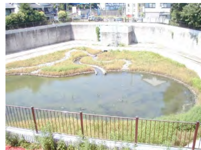
ビオトープ (三保第一雨水調整池)
