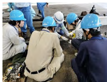
水道局と横浜ウォーターの連携 による水道技術者研修 (横浜市水道局) 令和6年6月
