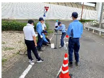
横浜ウォーターによる他都市支援 (埼玉県川口市) 令和5年9月
