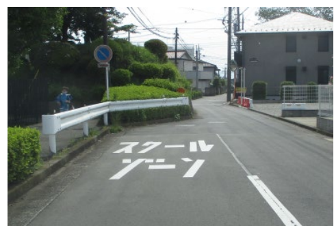
通学路 路面標示の補修
