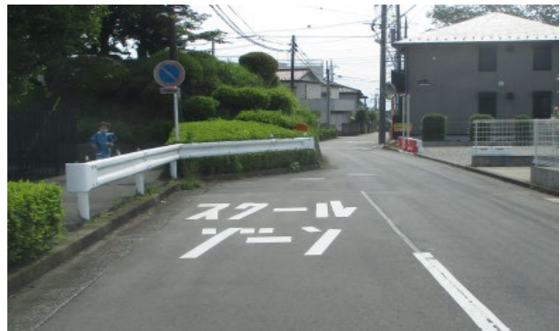
路面標示（スクールゾーン）補修
