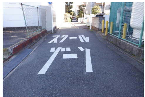
通学路 路面標示の補修
