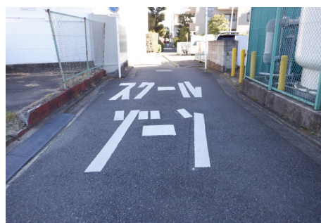
通学路 路面標示の補修
