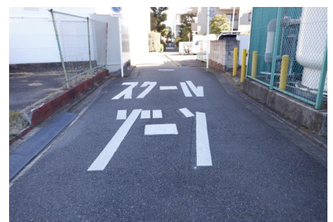
通学路 路面標示の補修
