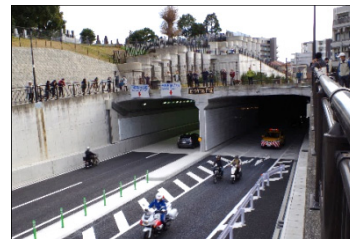
柏尾戸塚線（とつか地下道）
